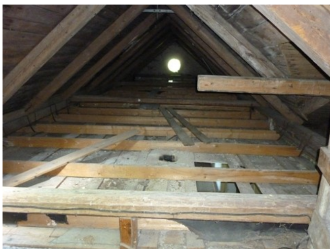
Obr 16. Stávající stav ne-pochůzího stropu
