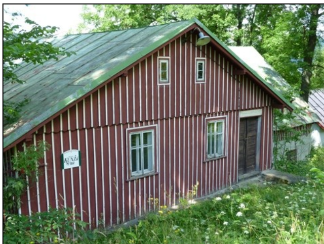
Obr.1: vstup do patra objektu od cesty 7/2010
