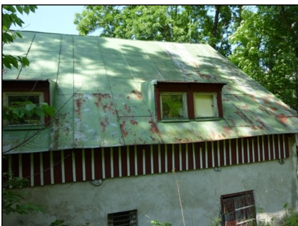
Obr 18. Těsnost střešního plechu je v dobrém stavu
