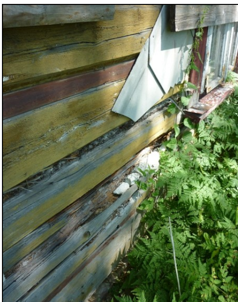
Obr 10. stávající stav roubení – jižní fasáda – Herlíkovice 7/2010
