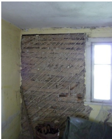
Obr 12. Skladba dřevěné stěny s vnějším deštěním a vnitřní omítkou na pomocné laťování -Herlíkovice 7/2010
