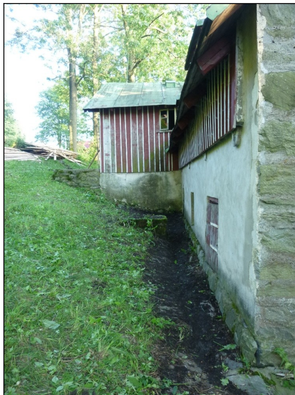
U kamenné zdi do ulice bylo zanesené odvodňovací kamenné koryto
