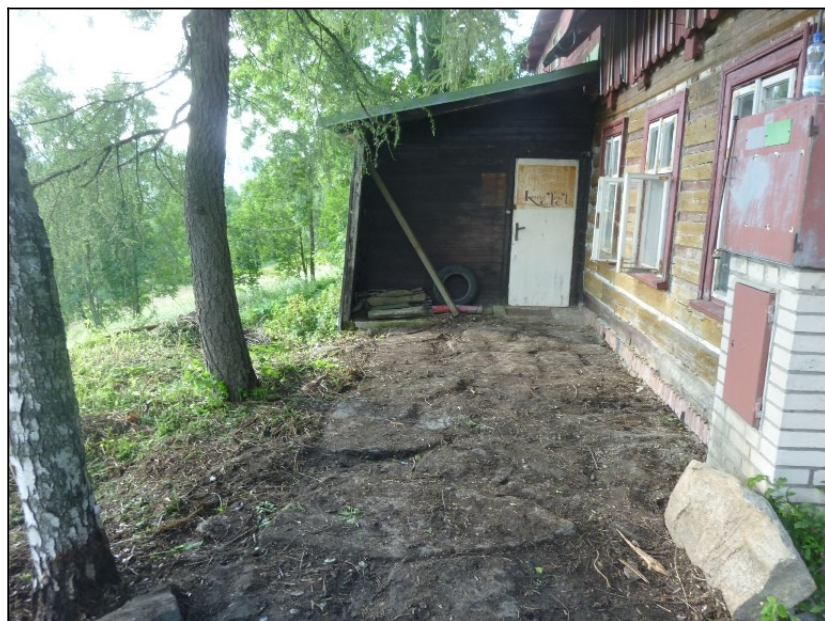
U zadního vchodu jsme pod vrstvou hlíny a kopřiv objevili krásnou kamennou terasu. V podezdívce pod roubením byly nalezeny dva větrací otvory
